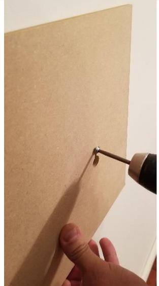
**8** Serrer les vis juste assez afin que le gabarit soit appuyé sur le mur et qu'il puisse glisser facilement.
