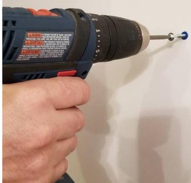
**6** Fixer les vis et laisser ½ pouce de la vis apparent.
