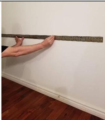
**1** Sélectionner l'emplacement du premier panneau et tracer une ligne au niveau.
